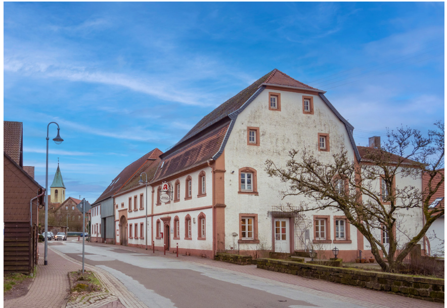
Denkmalgeschütztes Gebäude im Bereich der Hauptstraße, „Gasthaus Kurz“, Hauptstraße 119, errichtet in der zweiten Hälfte des 18. Jahrhunderts, spätbarocker Mansarddachbau mit Krüppelwalmen, in den Felsen gehauer Keller, Anbau, bezeichnet 1871
