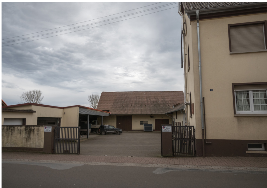
Nachverdichtungspotenzial durch den Umbau bzw. Rückbau von Scheunen mit anschließender Nutzungsänderung
