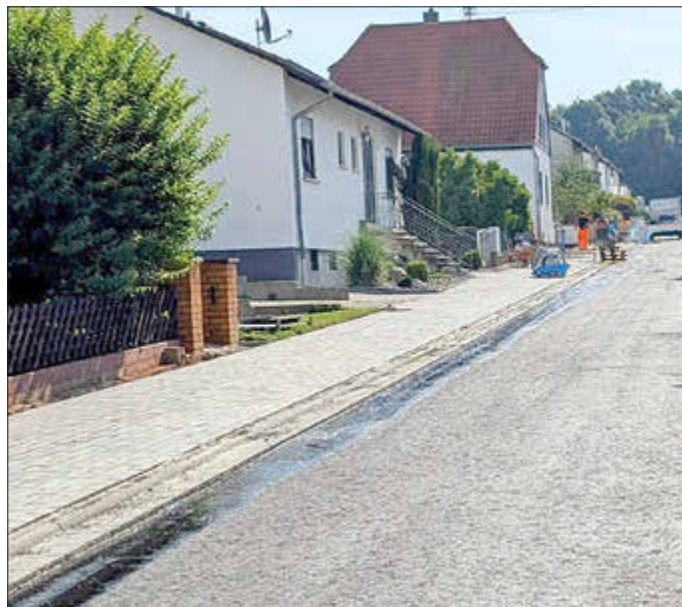
Die finalen Pflasterarbeiten im ersten Bauabschnitt in der Waldstraße.
