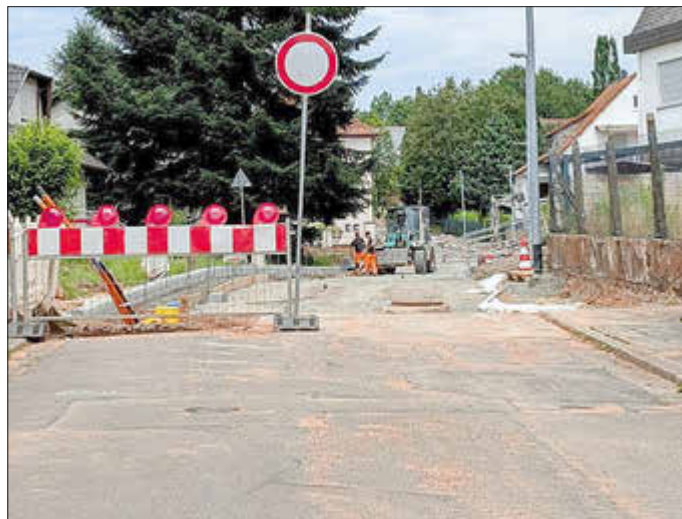
Straßeneinfassung im ersten Bauabschnitt der Friedhofstraße
