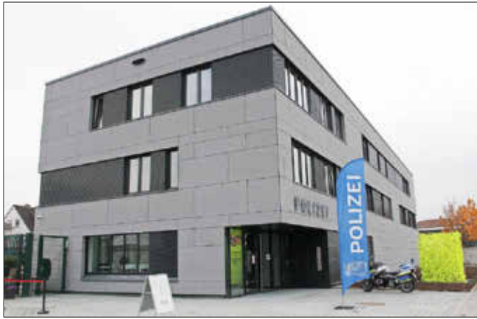
Das neue Gebäude der Polizeiinspektion Landstuhl in der Bahnhofstraße 54. (Foto: J. Schirra)
