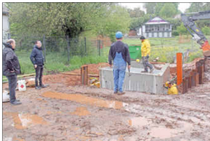
Stadtbeigeordneter Ludwig Linsmayer und der 1. Beigeordnete der Verbandsgemeinde, Marcus Klein, informierten sich über den Stand der Bauarbeiten in der Flurstraße (Foto: St. Laves)
