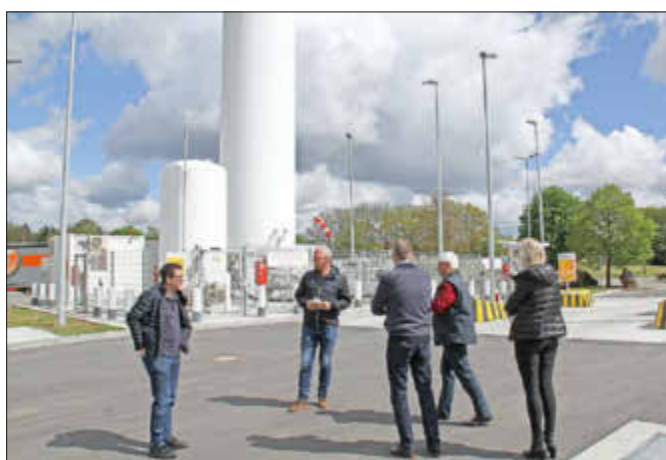
Der 1. Beigeordnete Marcus Klein und Bürgermeister Ralf Hechler (v.l.) ließen sich von Alfred Funk und dem Ehepaar Asti und Richard Schossböck die neue Tankanlage erläutern. Im Hintergrund ist der Kraftstoffbehälter für das Flüssig-Erdgas zu sehen (Foto: St. Layes).
