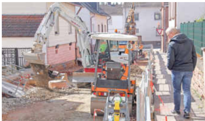
Auch in der Rathenaustraße in Miesenbach ruhen die Arbeiten seit Montag. Foto: Stefan Layes
