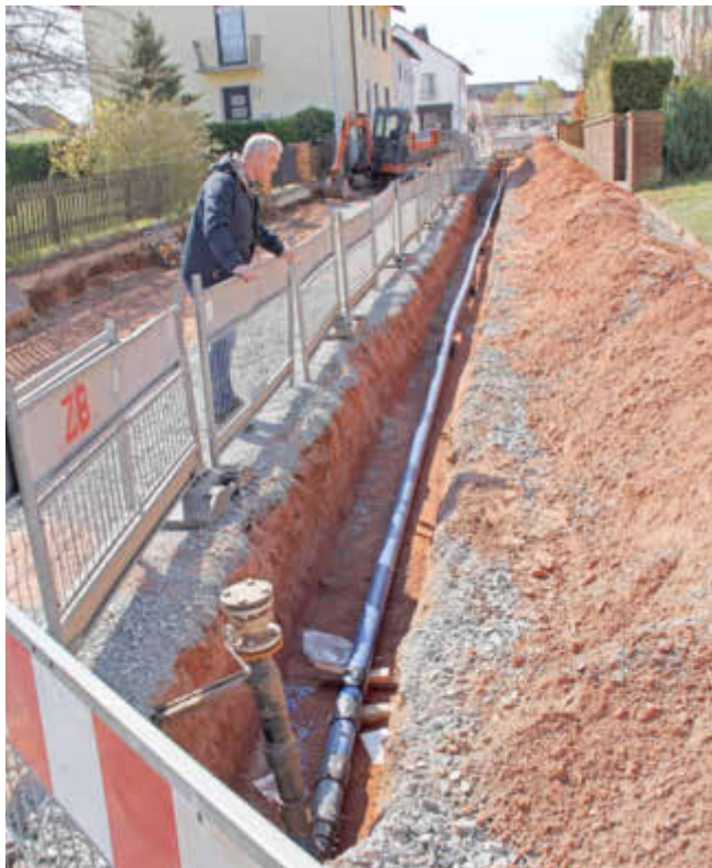
In der Nelkenstraße in Ramstein müssen die Bauarbeiten unterbrochen werden.
