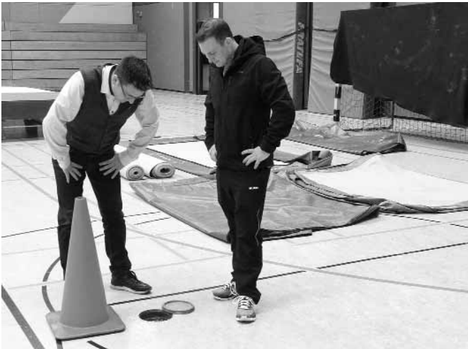
Erster Beigeordneter Marcus Klein und Sportwart Achim Wätold vom Turnteam-Sickingen bei einer ersten Begehung nach dem Schaden.
