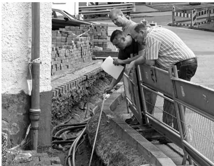
Stadtbeigeordneter Ludwig Linsmayer (rechts) begutachtet mit zwei Mitarbeitern der Stadtwerke die Verlegungsarbeiten in der Miesenbacher Hauptstraße (Foto: Verwaltung).
