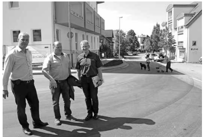
Bürgermeister Ralf Hechler und Stadtbeigeordneter Ludwig Linsmayer mit dem technischen Leiter der Stadtwerke Ramstein-Miesenbach, Jürgen Rosenkranz schauten sich die Bauarbeiten an (Foto: B. Hüge).
