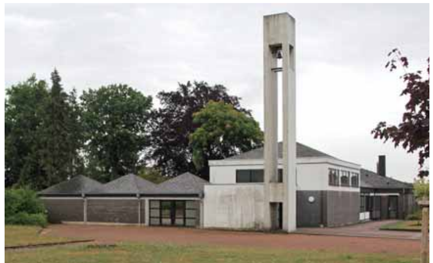
Die 1965 errichtete Aussegnungshalle soll durch einen Neubau ersetzt werden. (Foto: B. Hüge)
