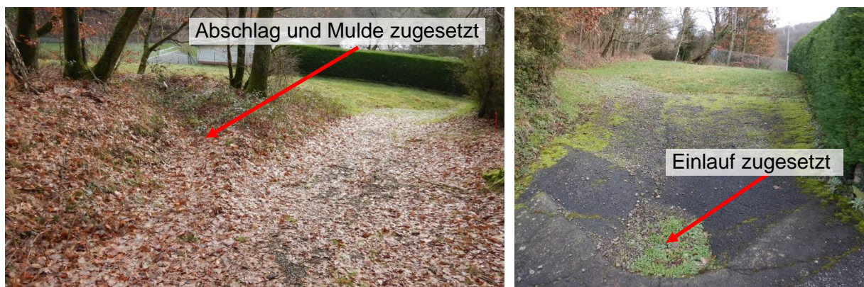
Abbildung 23 Situation Entwässerungsanlagen Wirtschaftsweg Blumenberg, 16.01.2023
