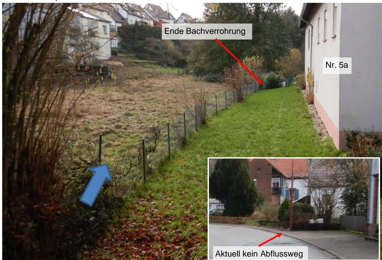
Abbildung 43 oberirdischer Abflussweg von der Steinwendener Straße
