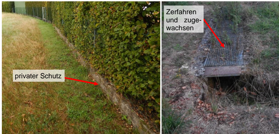
Abbildung 35 Situation über der Straße Ober der Neuwiese
