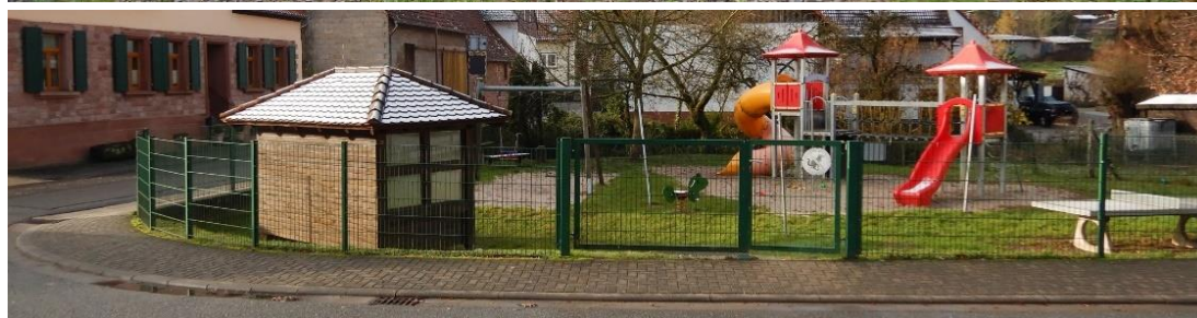
Abbildung 18 oben: Außengebietswasserfassung Wirtschaftsweg, unten: Ansicht Spielplatz vom Wirtschaftsweg
