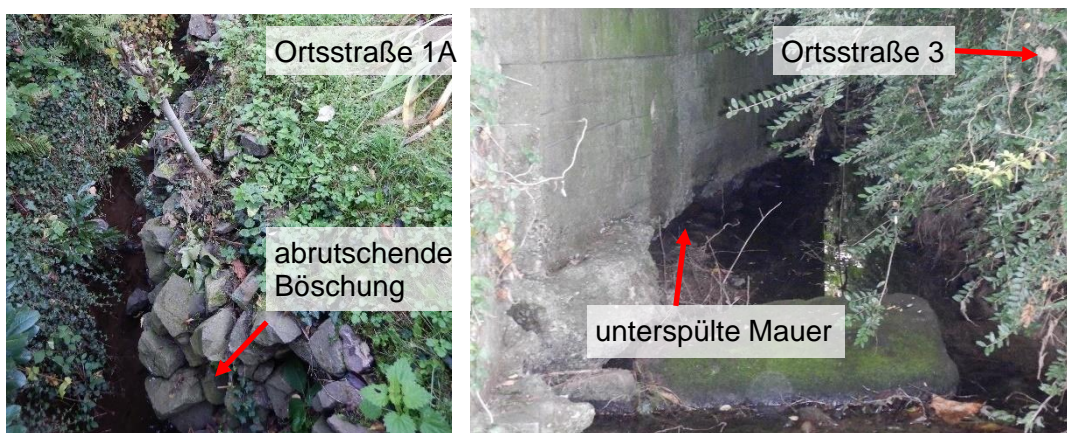
Abbildung 16 Böschungsverbau Schwanderbach
