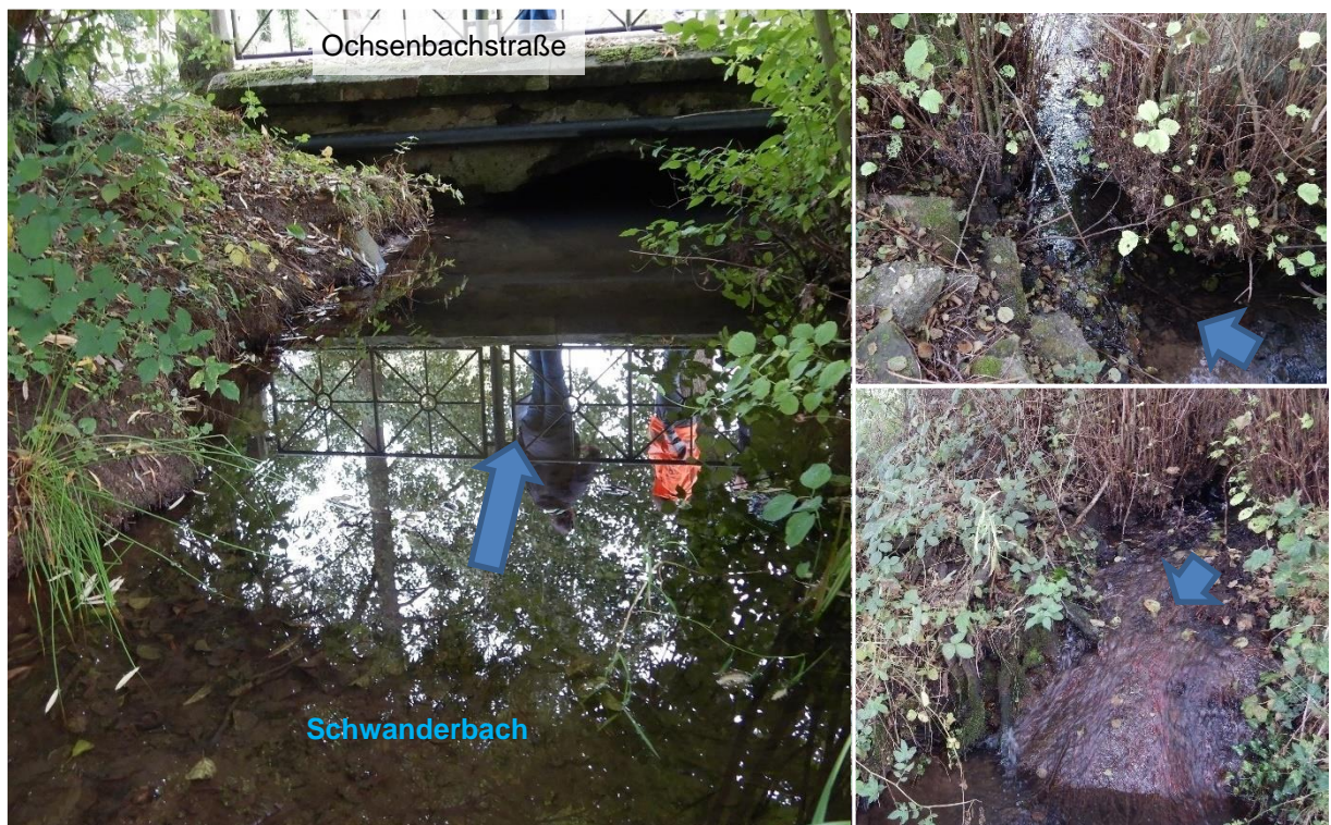
Abbildung 59 Schwanderbach Brücke Ochsenbachstraße
