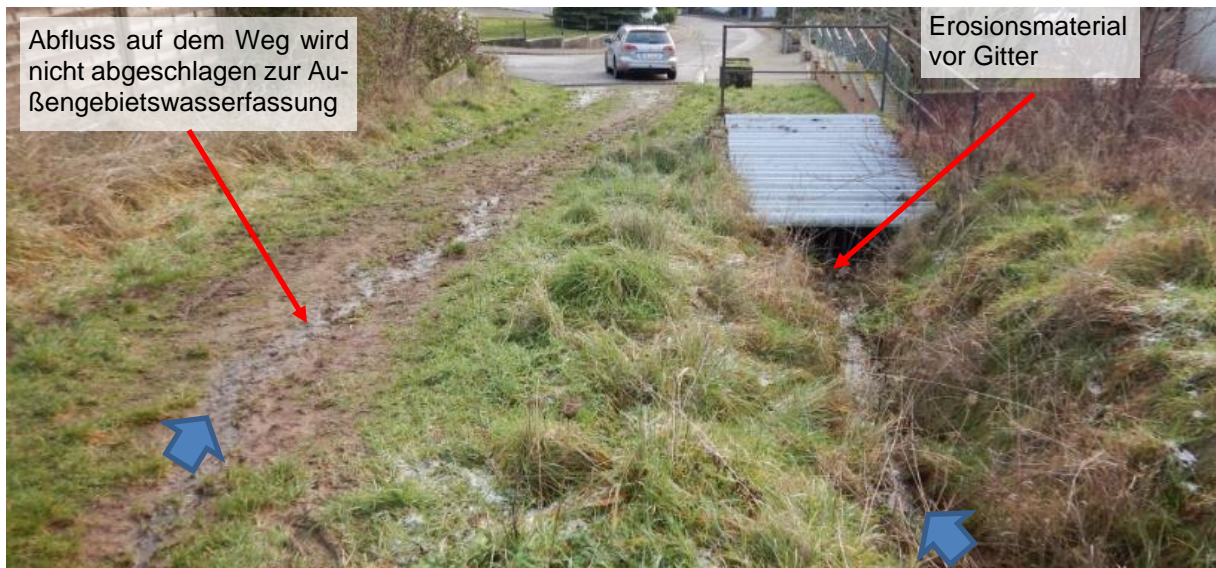
Abbildung 52 Außengebietswasserfassung oberhalb Friedenstraße
