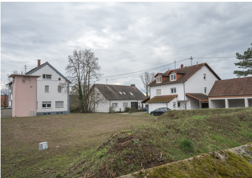
Freifläche an der Hauptstraße infolge des Rückbaus des historischen Gebäudes Hauptstraße Hs.Nr. 91
