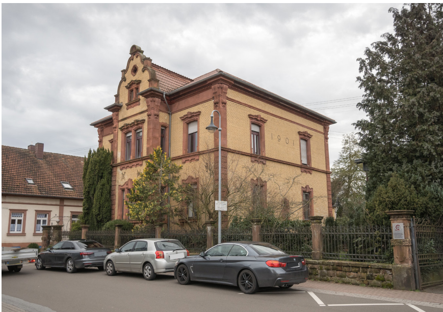
Denkmalgeschützte Villa, Hauptstraße 112, errichtet 1901, stattliche spätgründerzeitliche Walmdachvilla
