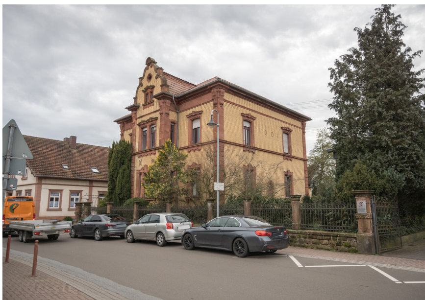
Denkmalgeschützte Villa, Hauptstraße 112, errichtet 1901, stattliche spätgründerzeitliche Walmdachvilla
