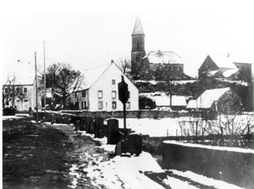
Blick von der Miesbacher Str. auf den ehem. Turm
