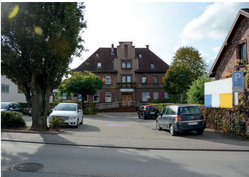
Parkplatz an der Landstuhler Straße; dahinter Bestands-Bebauung (innerhalb des Plangebietes)
